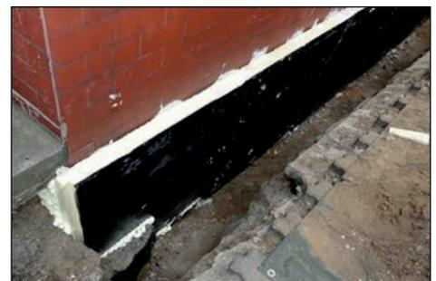
1. Das Fundament austrocknen lassen (1-2 Wochen), alle Klüfte und Schrunden mit Zementmörtel verputzen
