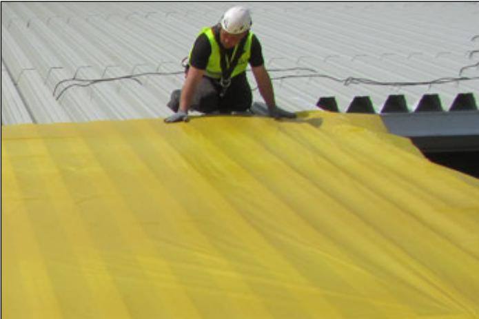
Platten TM/TM FR werden direkt an die vorhandene Unterkonstruktion montiert (bestehendes Dach, Trapezbleche). Von großer Bedeutung für das System ist die Anwendung der Dampfsperffolie.
