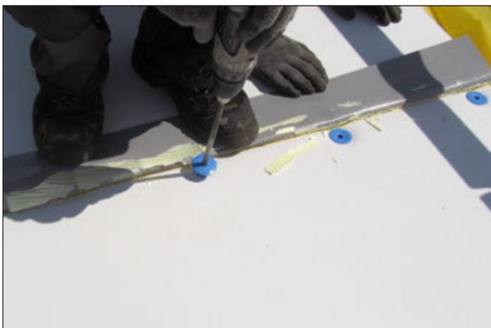
Die Platten werden mit entsprechenden, zum System passenden, Verbindungsmittel verankert.
