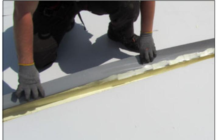
Die Längsüberlappung wird mit einem Überlappungsfalz anliegender Platte abgesichert.
