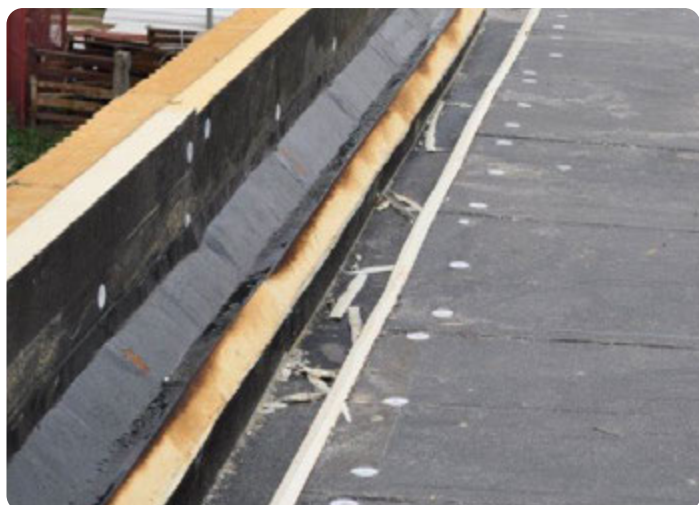
Docieplenie ściany szczytowej (ogniomuru) z korytem rynny wewnętrznej
