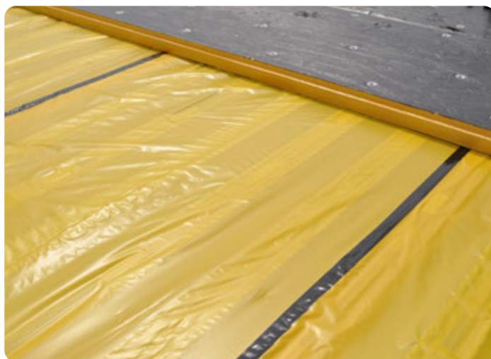
Kotwienie płyt do podłoża stalowego
