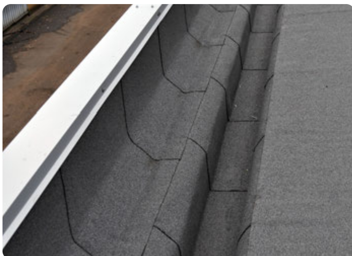
Widok po montażu
