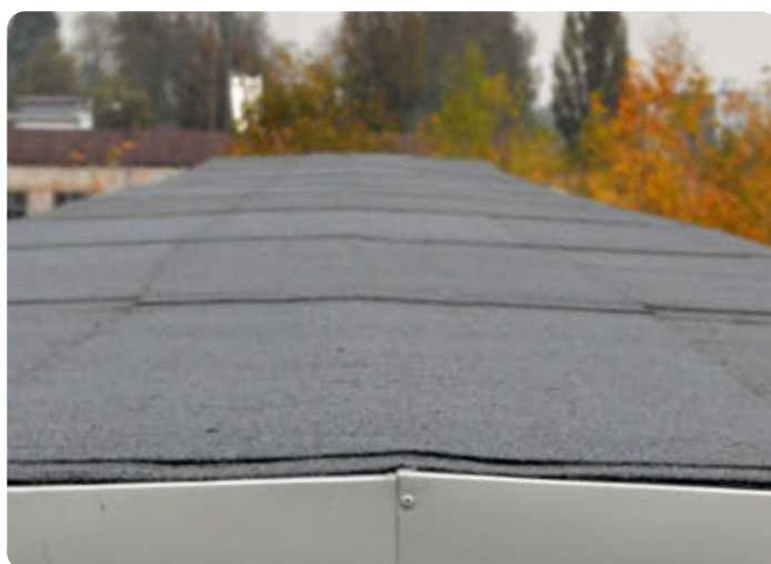
Kalenica po montażu
