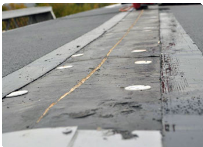
Montaż w kalenicy
