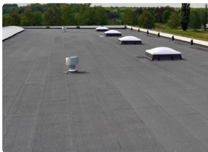
Widok po montażu i zgrzaniu papy wierzchniej
