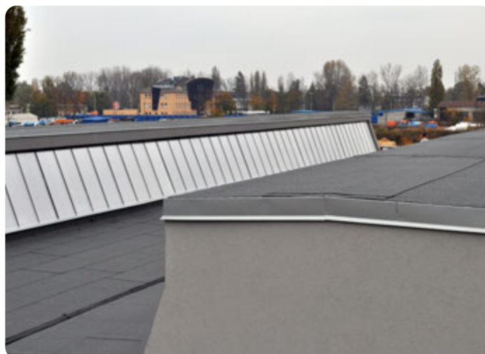
Dach płaski - świetliki
