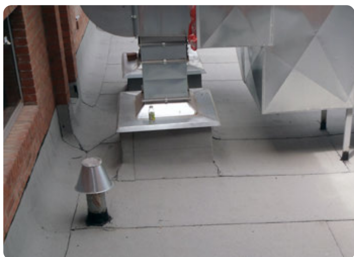
Dostęp do urządzeń wentylacyjnych
