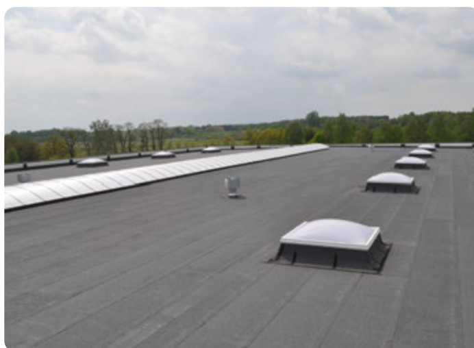
Widok dachu po zakończonym montażu systemu ThermaBitum (FR)
