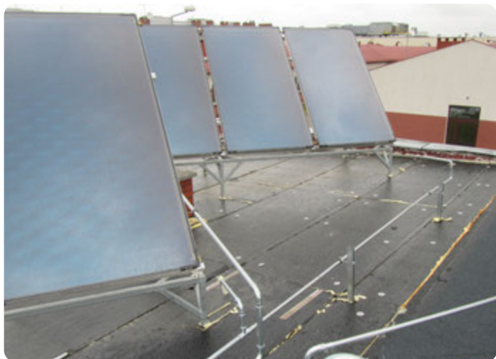
Montaż systemów energii odnawialnej
