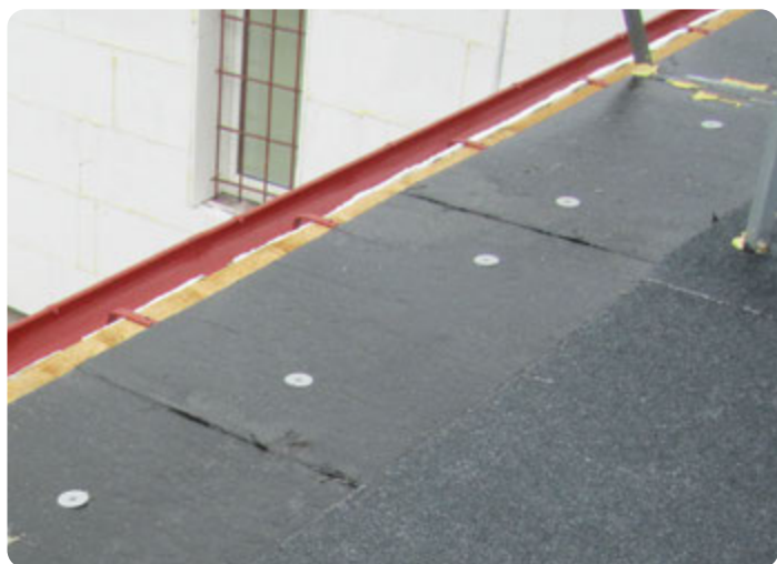
Okap przygotowany do zgrzewania papy wierzchniej
