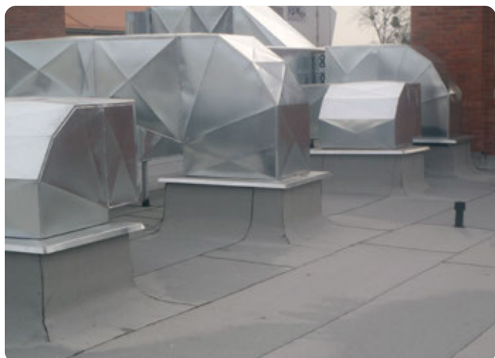
Instalacja wentylacyjno-klimatyzacyjna na dachu płaskim wykonanym w systemie ThermaBitum
