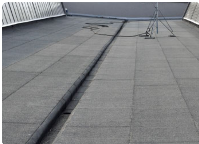
Widok po montażu
