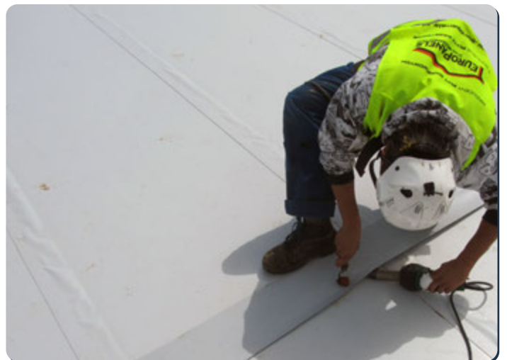
Handschweißen- Membranstreifen an der Querverbindung
