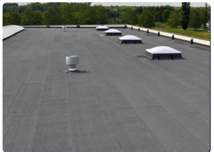
Ansicht nach der Montage und nach dem Verschweißen der Pappen
