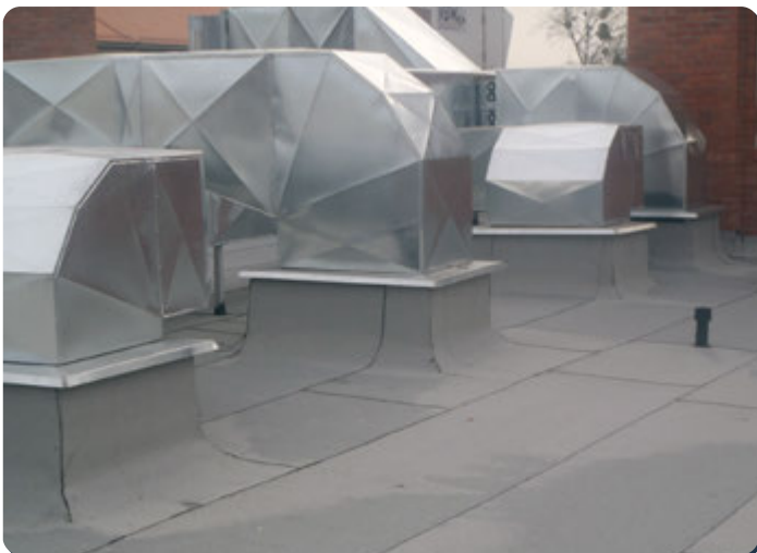
Montage der Klimaanlage auf einem Flachdach im System ThermaBitum
