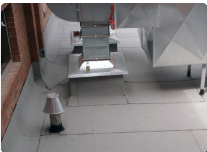
Zugang zur Klimaanlage
