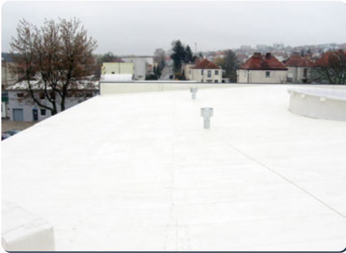
Dacheindeckung mit Elementen von Lüftungssystem
