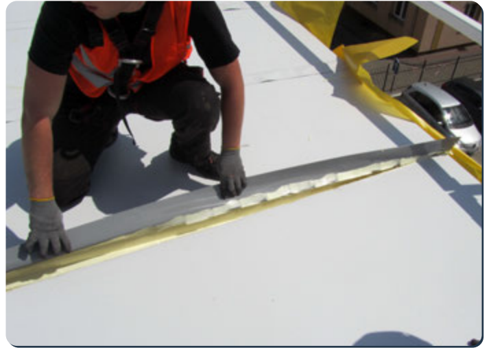
Überlappungsmembran an den Längsstoß
