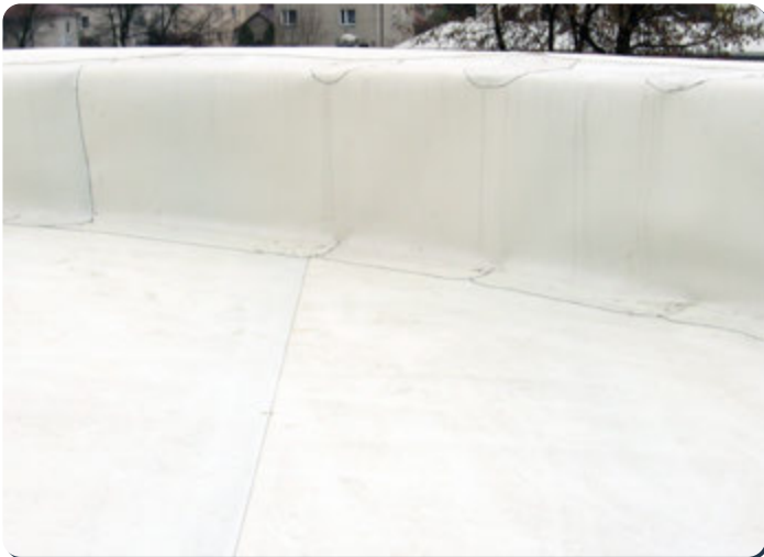
Verbindung des Dachs mit der Mansarde / Giebelwand
