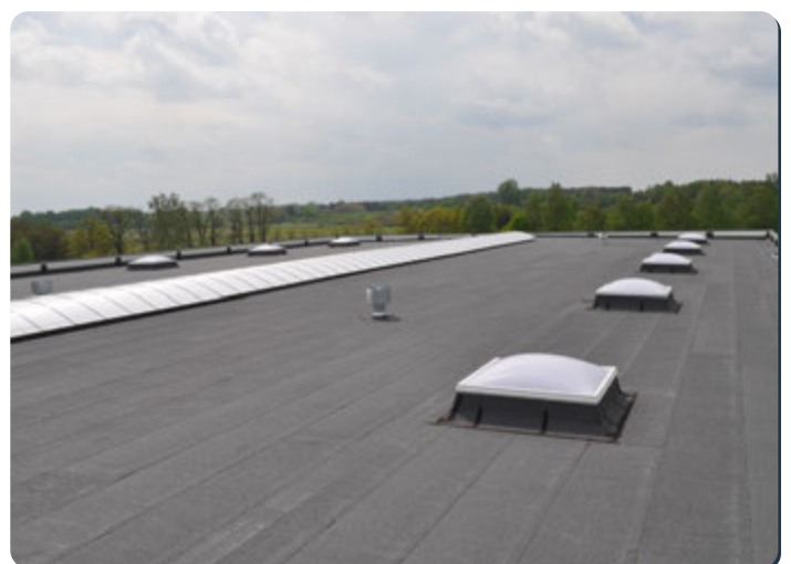
Ansicht nach abgeschlossener Montage des Systems ThermaBitum (FR)
