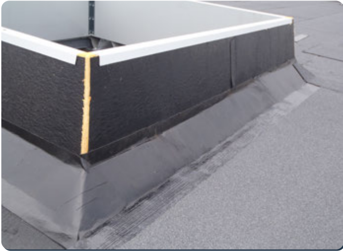
Keil 100x100 an dem Stoß mit der Rauchklappe
