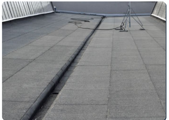
Ansicht nach der Montage
