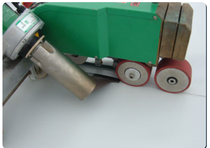
Schweißen mit einem Schweißautomat- die Überlappungsmembran an der Längsverbindung
