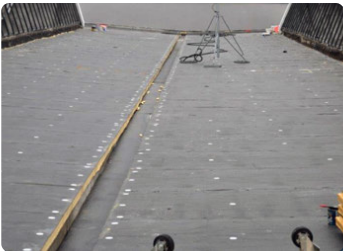
Der Kanal der Innenrinne während der Montage
