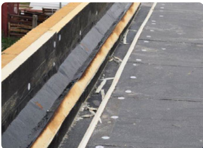
Dämmung der Giebelwand mit der inneren Mulde
