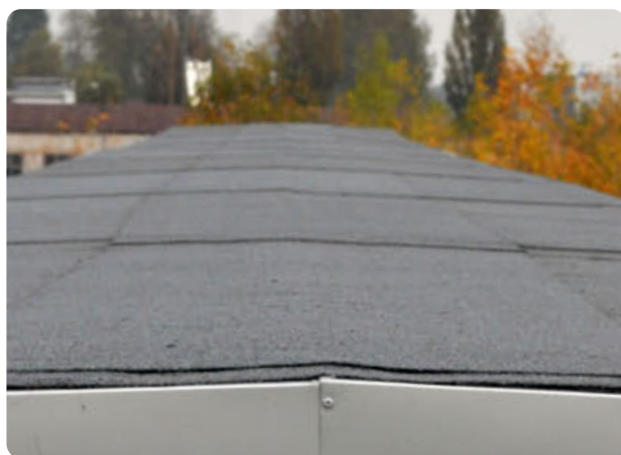
Ansicht nach der Montage
