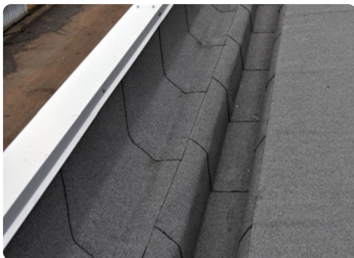
Ansicht nach der Montage
