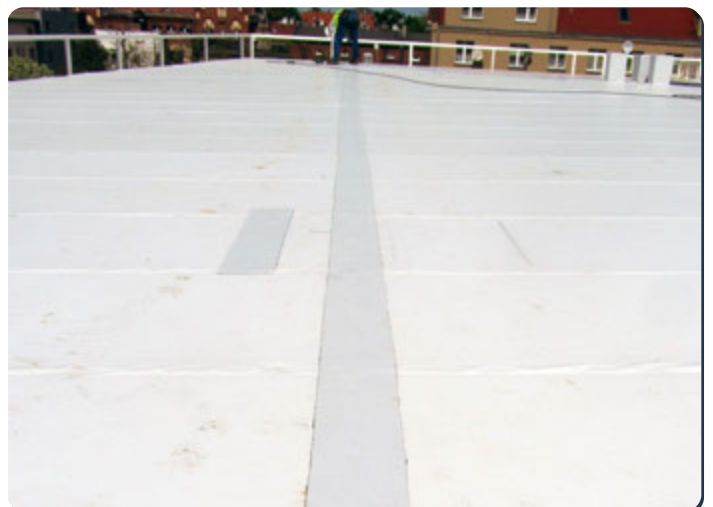
Querstoß mit einem angeschweißtem Membranstreifen
