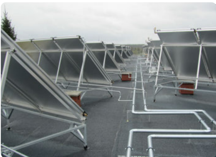
Zugang zu den Systemen erneuerbarer Energie
