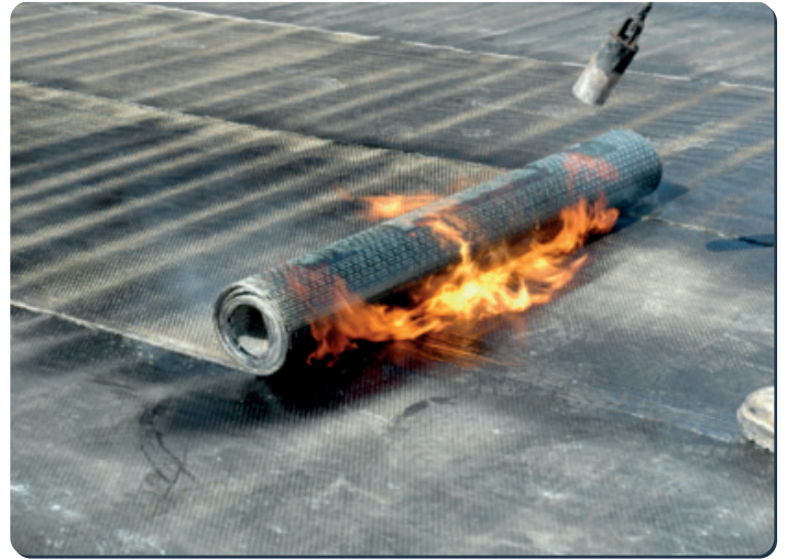
Der Schweißpunkt (Brenner) wird auf die Kontaktstelle der beiden Pappen ausgerichtet, d. h. auf die Kontaktstelle der Teerpappe mit der Schweißbahn (aus der Rolle).
