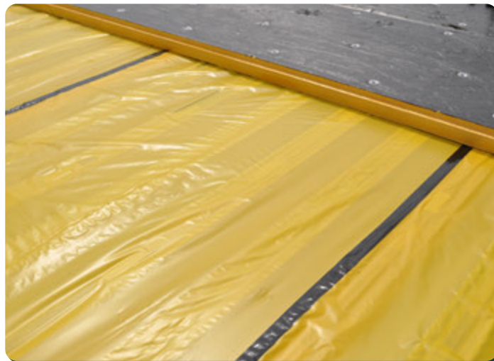
Verankern der Platten an den Stahluntergrund
