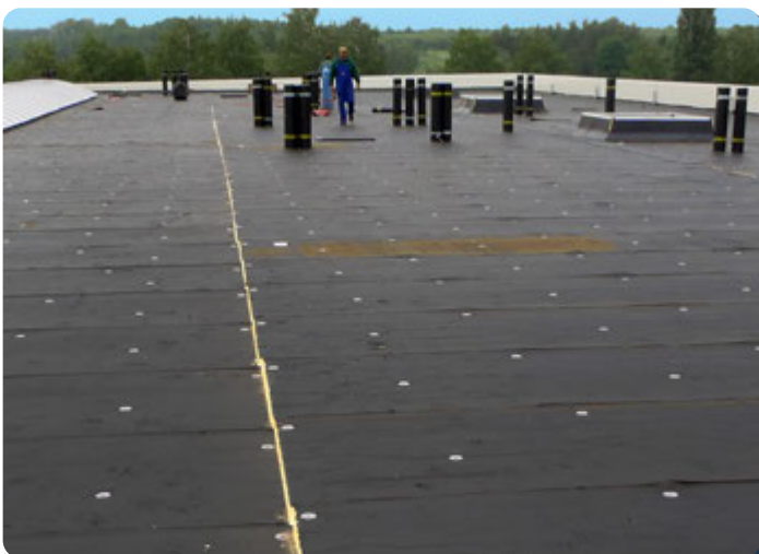
Montage der Platten ThermaBitum auf der ganzen Dachdeckschicht
