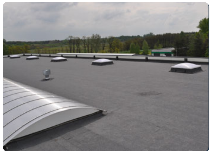
Dacheindeckung im System ThermaBitum (FR)
