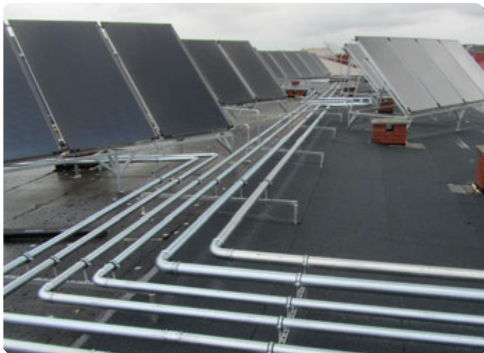
Montage der Systeme, erneuerbarer Energie, auf einem Flachdach im System ThermaBitum
