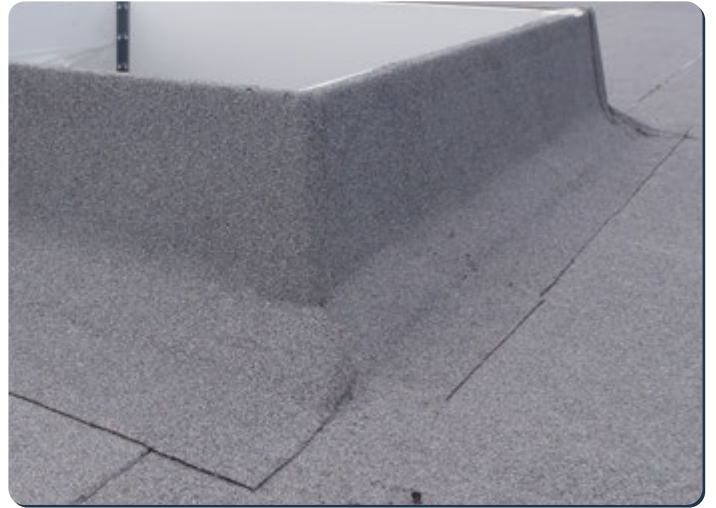
Endverarbeitung – Polymehrbitumen-Schweißbahn
