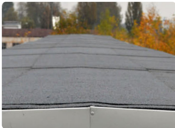
Taknock efter montering
