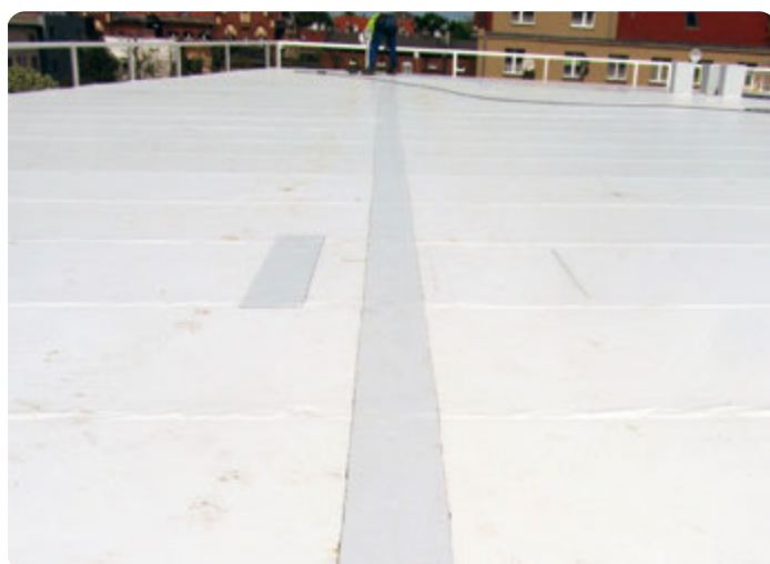
Tvärskarv mellan skivororna med påsvetsad membranremsa
