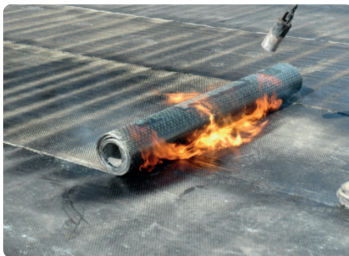
Brännaren riktas mot skarven mellan underlagspappen (skivinklädnad) och ytpappen (rullas ut från rulle)
