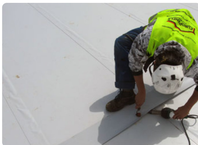
Manuell svetsning- membranremsa i tvärskarven
