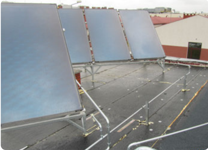
Montering av system för förnybar energi
