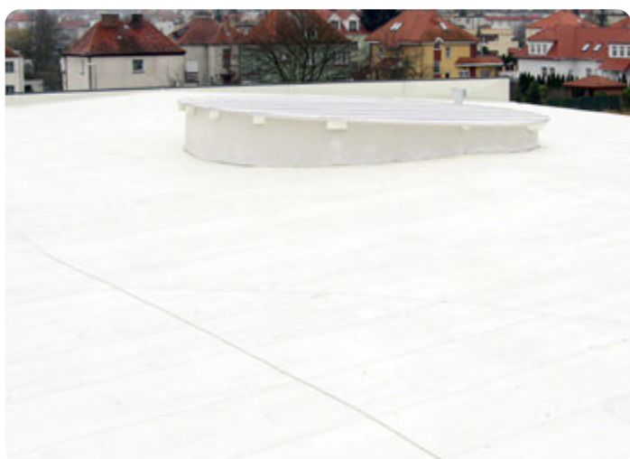
Tak efter avslutad montering
