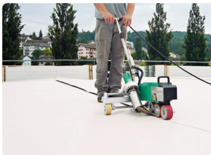
Svetsning med svetsautomat- överlapp i längskarven
