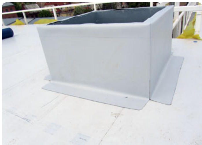
Slutbehandling av takfönster / röklucka
