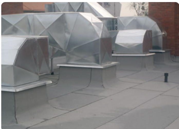
Ventilations- och luftbehandlingsanläggning på plantak utfört med ThermaBitum systemet
