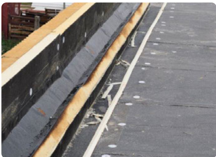
Värmeisolering av gavelvägg (brandmur) med invändig ränna
