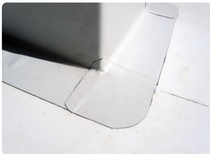
Slutbehandling av hörna
