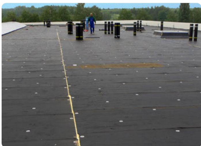
Montering av ThermaBitum skivorna i taklutningen
