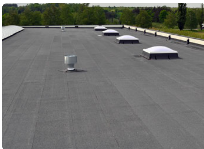
Vy efter montering och svetsning av ytpappen
