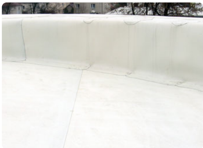
Takanslutning med brandvägg / gavelvägg
