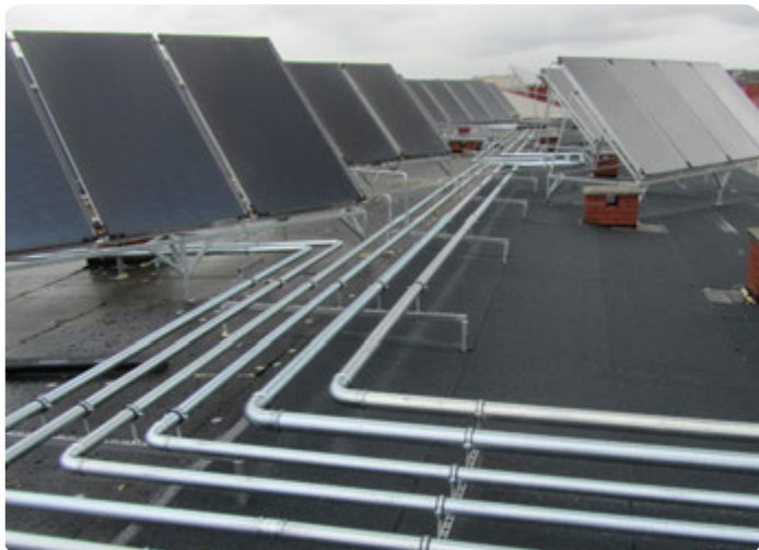
Anläggning för förnybar energi på plantak isolerat med ThermaBitum systemet
