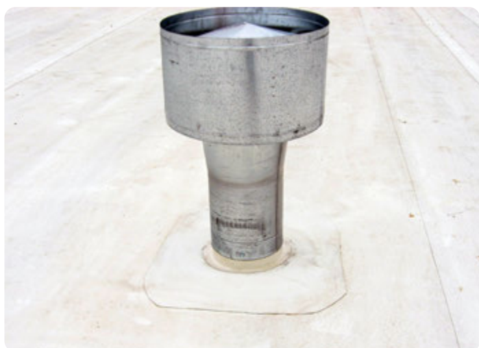
Slutbehandling av ventilationskanal
