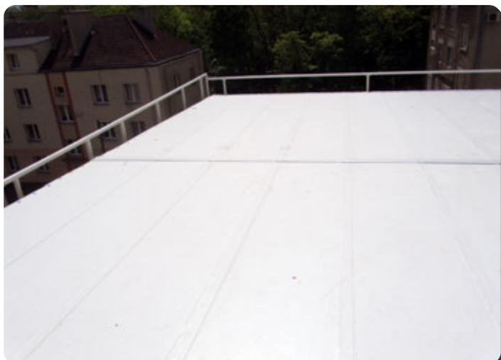
Les plis du recouvrement sur le joint longitudinal des panneaux
