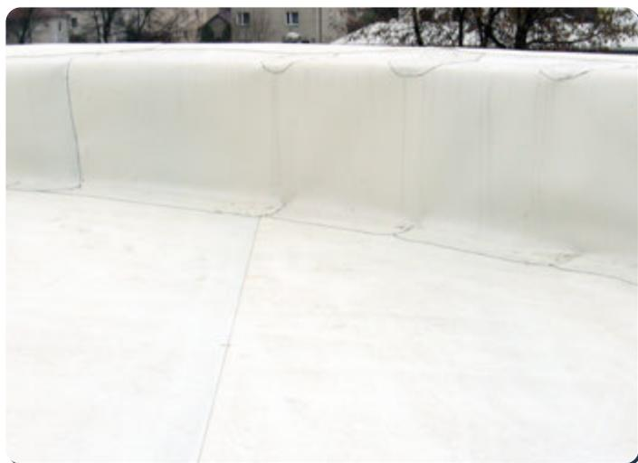
L'assemblage de la toiture avec l'attique / mur pignon
