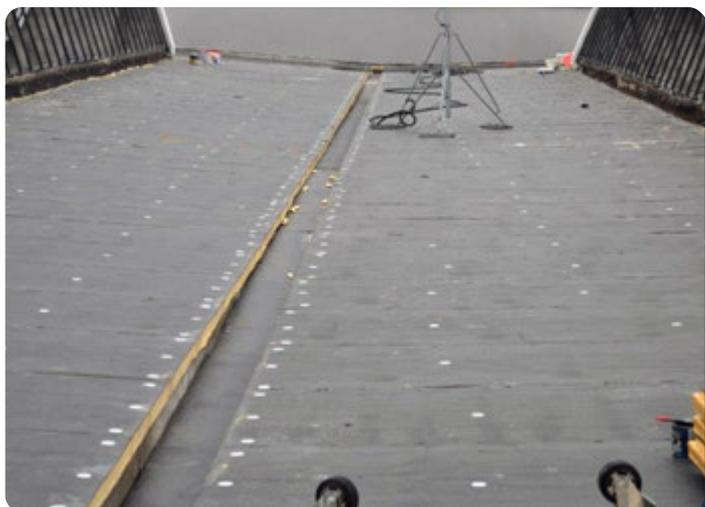
Rigole de la gouttière intérieure pendant le montage
