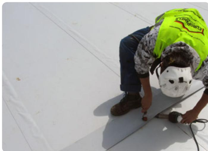
Soudage manuel- une bande de la membrane sur le joint transversal
