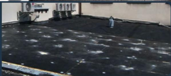
Grâce à l'utilisation du noyau PUR, l'épaisseur des panneaux **ThermaBitum** peut être réduite de moitié par rapport aux autres systèmes contenant par exemple le polystyrène expansé ou la laine minérale. C'est assez important dans le cas d'une modernisation d'une toiture existante quand on doit prendre en compte la hauteur des murs pare-feu qui limite l'ajout arbitraire des couches d'isolation successives.
