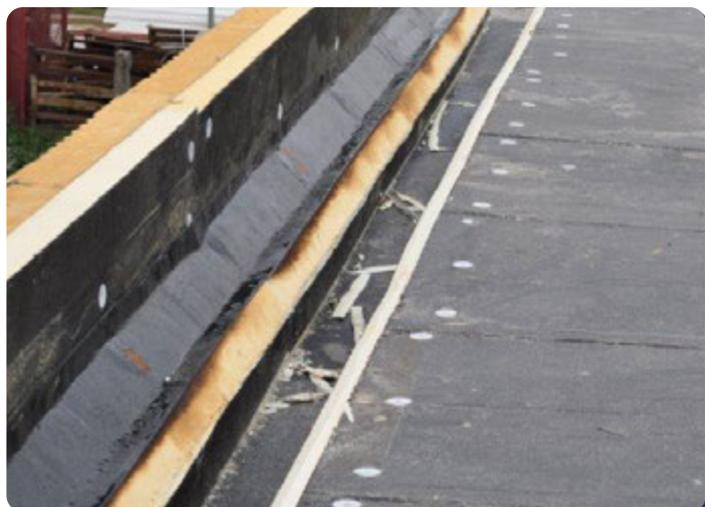
Calfeutrage supplémentaire du mur de pignon (mur pare-feu) avec une rigole issu de la gouttière extérieur
