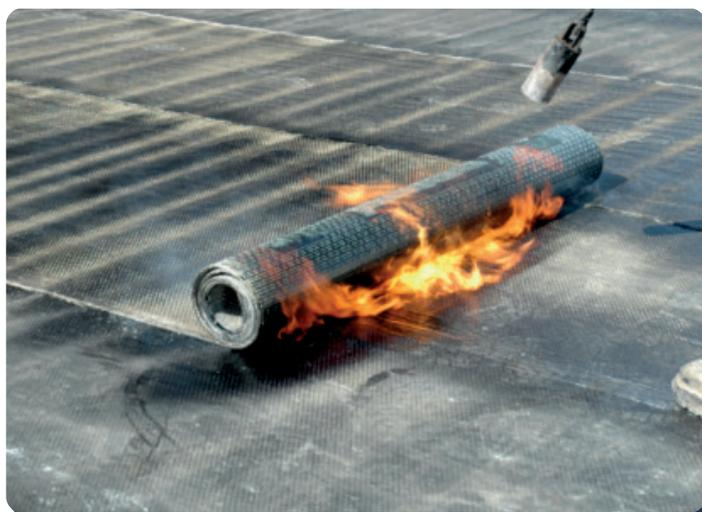
Le point de soudage (chalumeau) dirigé vers le joint entre le carton-feutre du dessus (revêtement du panneau) et du fond (en rouleau)
