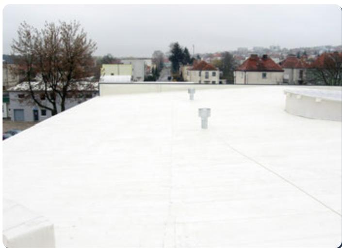
Le joint transversal protégé par une bande de membrane soudée
