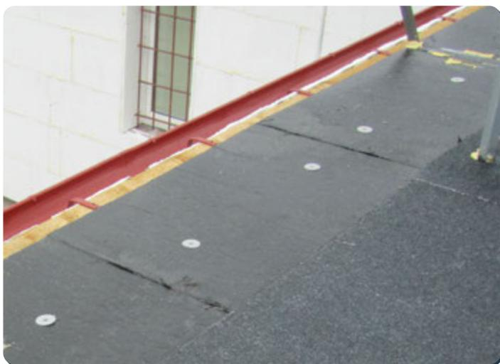
L'avant-toit préparé pour le soudage du carton-feutre de dessus
