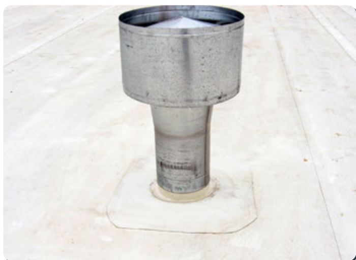
Ventiliacijos kanalo apdaila
