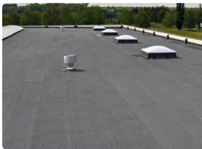
Išvaizda po montavimo ir viršutinio tolio suvirinimo
