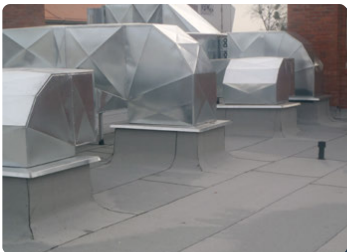
Ventiliacijos ir oro kondicionavimo instaliacija ant plokščiojo stogo, atlikto ThermaBitum sistemoje
