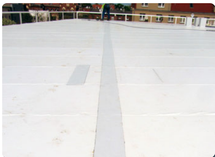
Ventiliacijos kanalo apdaila
