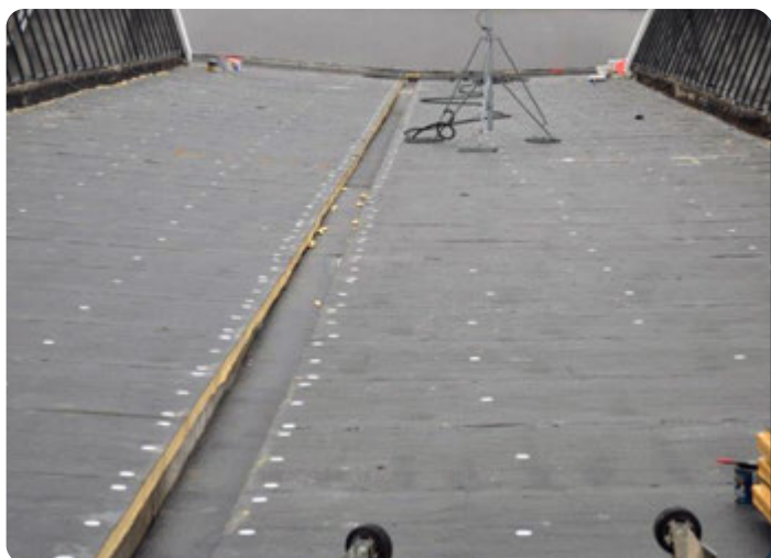
Vidinio lietvamzdžio vaga montavimo metu
