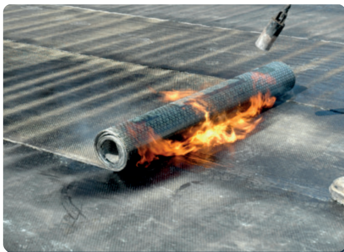
Suvirinimo punktas (degiklis) nukreiptas į tolių sąlytį- pagrindo (plokštės apdailos medžiaga) ir viršaus (išvyniojamas iš ritinio)
