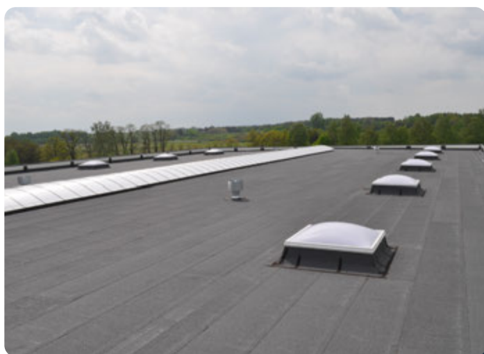
Stogo išvaizda po ThermaBitum (FR) sistemos montavimo
