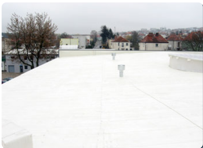
Skersinė plokščių sandūra apsaugota suvirinta plėvelės juoste
