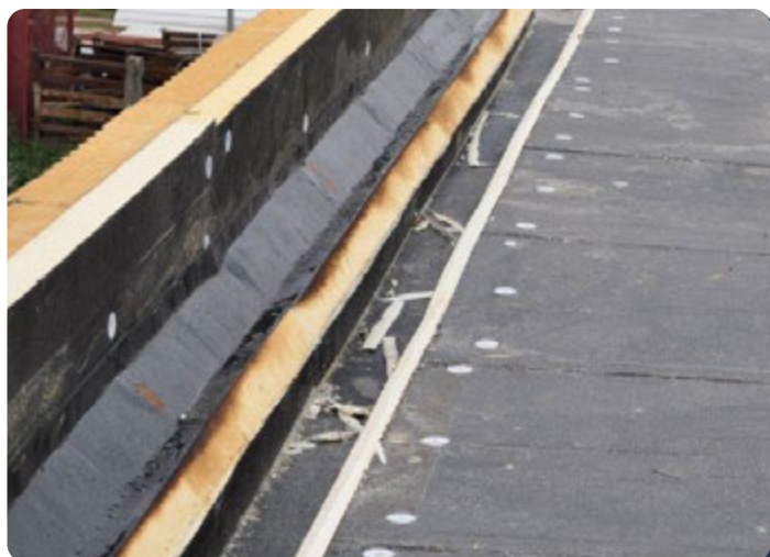
Dvišlaitės sienos šildymas (priešgaisrinė siena) su vidinio lietvamzdžio latakais
