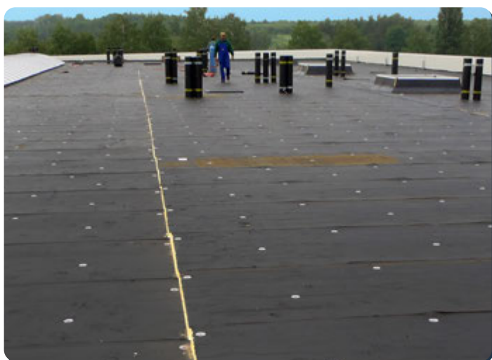
ThermaBitum plokščių stogo šlaite montavimas
