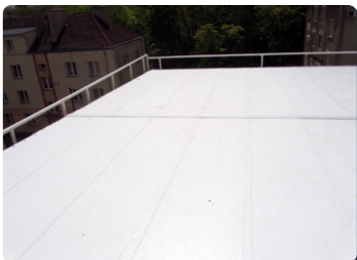
Uždėjimo klostė ant plokščių išilgos sandūros
