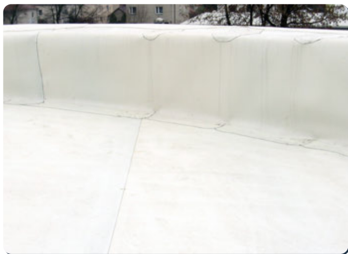
Stogo su atika/stogo šlaitų siena jungimas
