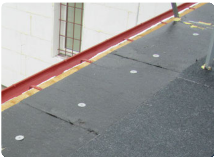
Stogo nuosvyra paruošta viršutinio tolio suvirinimui
