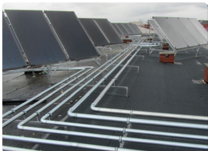
Atsinaujinančios energijos instaliacija ant plokščiojo stogo, ThermaBitum sistemoje
