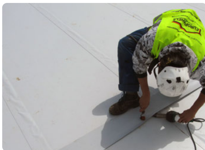
Rankinis suvirinimas- plėvelės juostelė ant skersinės sandūros
