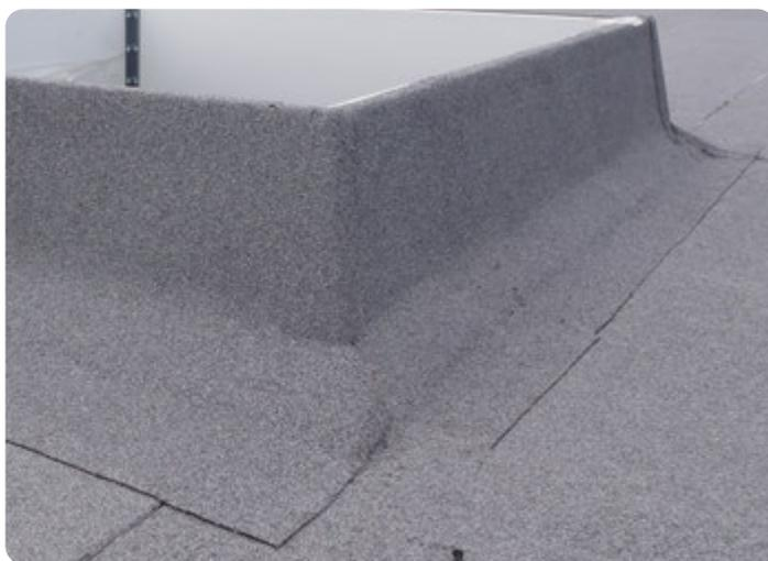
Endverarbeitung – Polymehrbitumen-Schweißbahn
